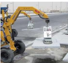
VM mit VAKUUM-STEINMAGNET SM Vakuum-Anbaugerät
