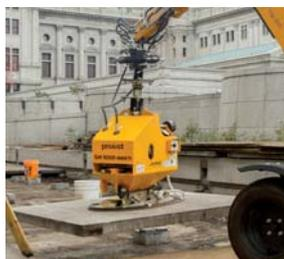
VM mit Vakuum-Anbaugerät SH-1000-MINI-H
