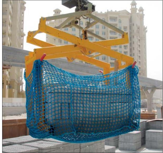
Mechanischer Scherengreifer SG
