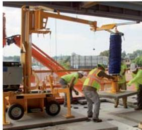
JUMBOMOBIL JM-VARIO Vakuum-Plattenverlegemaschine
