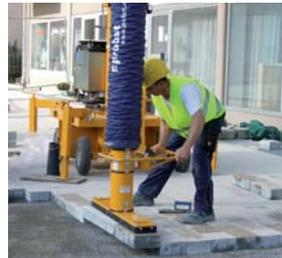
JUMBOMOBIL JM-VARIO Vakuum-Plattenverlegemaschine
