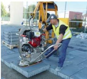
POWERJET PJ-1650-B Vakuumanbaugerät
