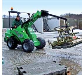
Hydraulische Verlegezange am Minilader
