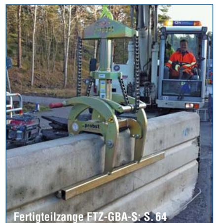
Fertigteilstange FTZ-GBA-S: S. 64
